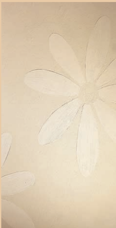
Na ścianie pokrytej tynkiem Optiva Formo w kolorze H484, wykonany został kwiatowy wzór przy użyciu tynku Optiva Formo w odcieniu F484.
